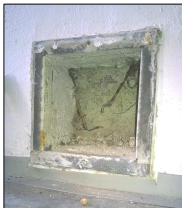
Příváděcí otvor do mezery za předstěnou
